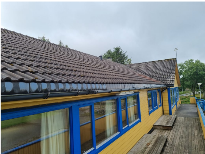
Foto 10 takflate mot nord
