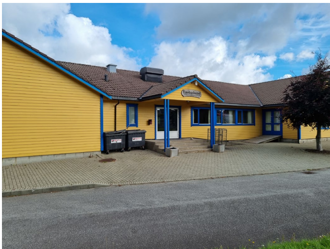
Foto 25 fasade mot sør med trapp og ramper
