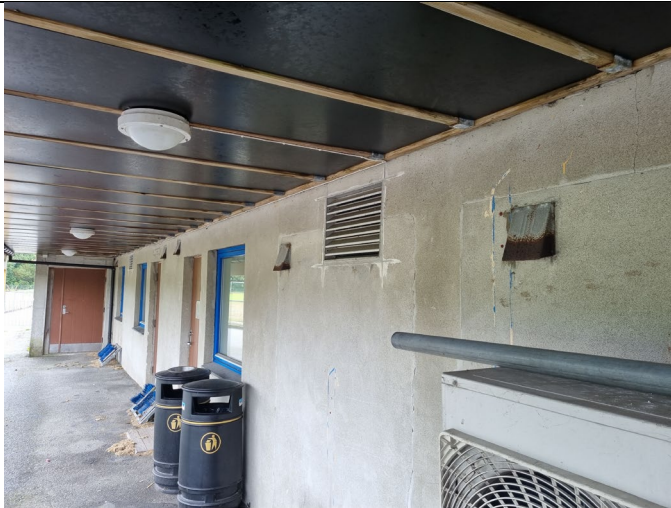
Foto 16 veggventilar i kjellervegg mot nord
